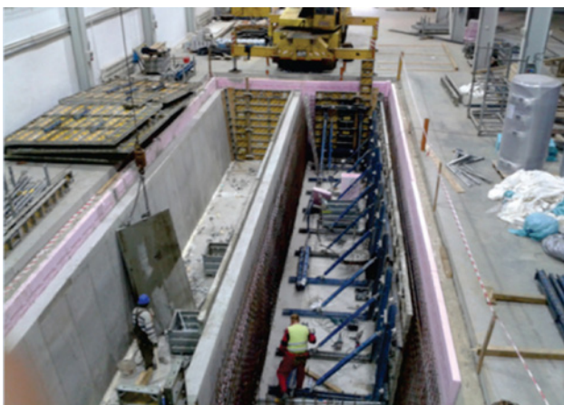
Výstavba podzemných vodných akumulčných zásobníkov tepla s objemom 150 m 3 .
