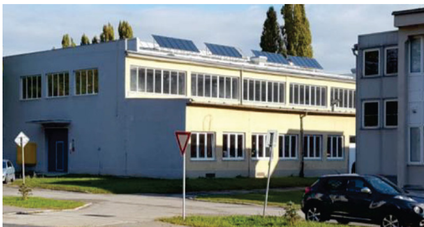
Budova laboratórií SvF TUKE (VUKONZE) so solárnymi panelmi na streche
