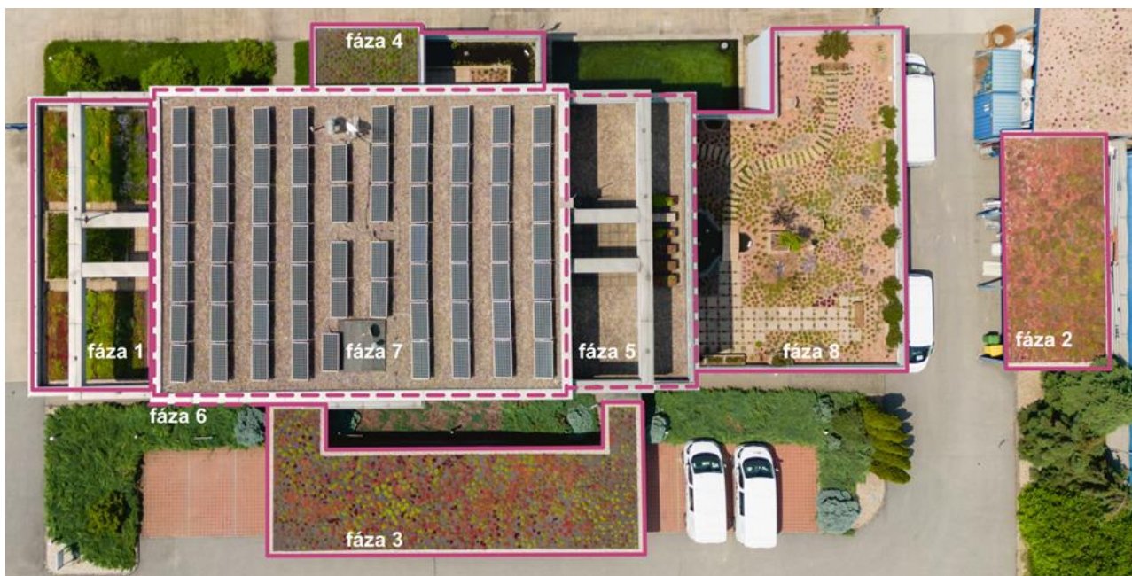
Obr. 1: Pohľad na strešné konštrukcie záujmového územia s rozdelením na fázy
