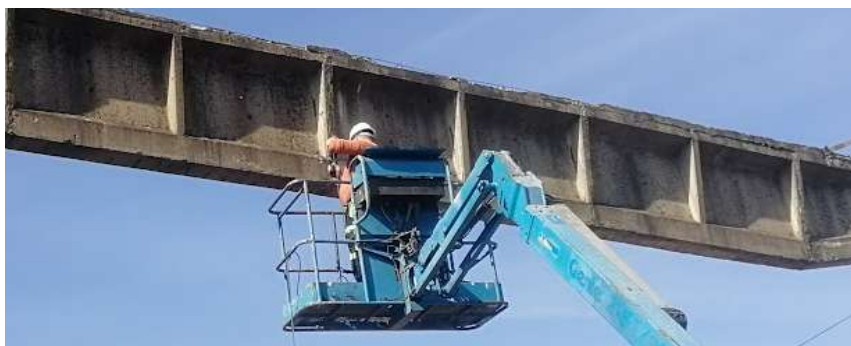
Diagnostika predpätého nosníka žeriavovej dráhy
