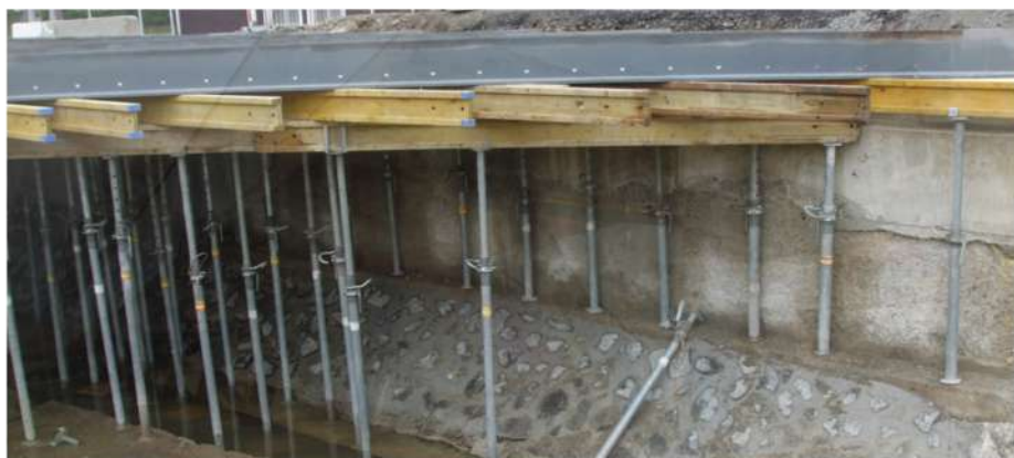
Monitoring konštrukcie spriahnutého doskového mostu vo fázach výstavby
