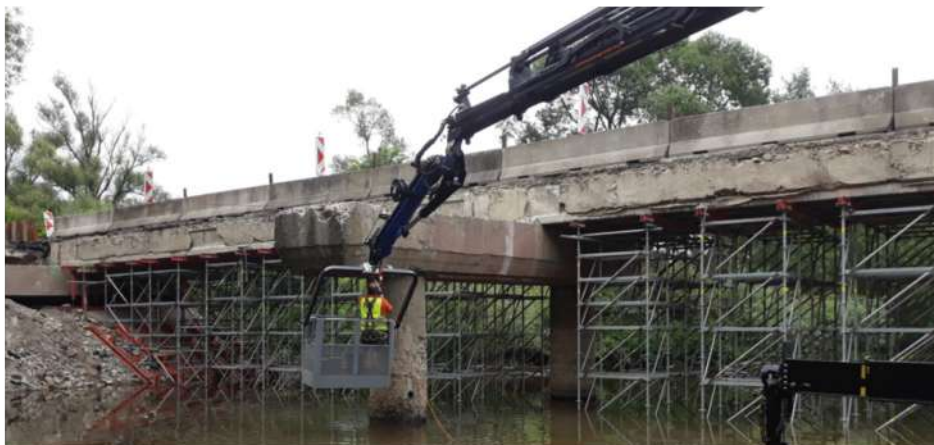
Diagnostika spodnej stavby mosta – odber vzoriek (jadrové vŕtanie)
