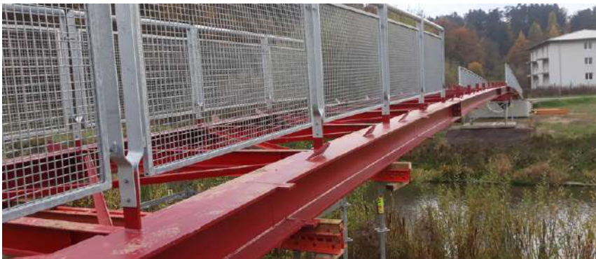
Overenie hrúbky náterov na ocelevej konštrukcie
