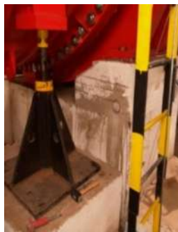
Diagnostika kotevných blokov pre technologické zariadenia
