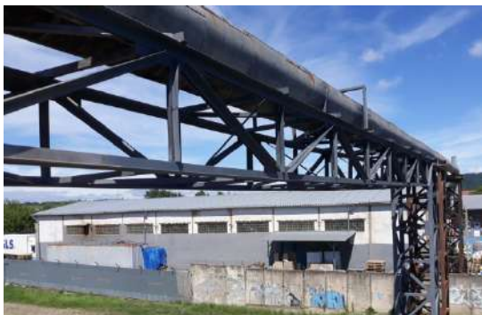
Diagnostika ocelevej konštrukcie technologickej lávky – korozívne úbytky
