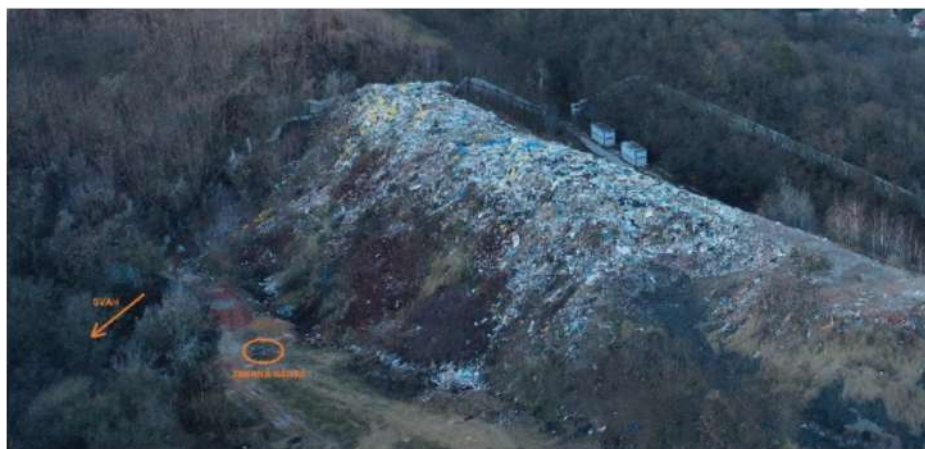
Posúdenie stability svahov skládky
